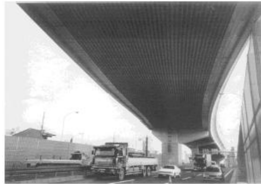
Figura 6. Alporas ancladas a la parte baja de un viaducto elevado en Japón, con esto se reduce el nivel de ruido hacia los residentes cercanos.
