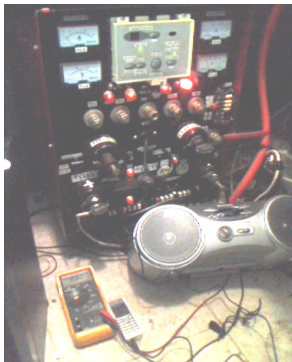
Figura 4.5.1.2. Fotografía que muestra el uso del subsistema convertidor con cargas planeadas: celular, radiograbadora, etc., se observa que es corriente directa o corriente continua (c.d.) dando un buen comportamiento, fuente propia.
