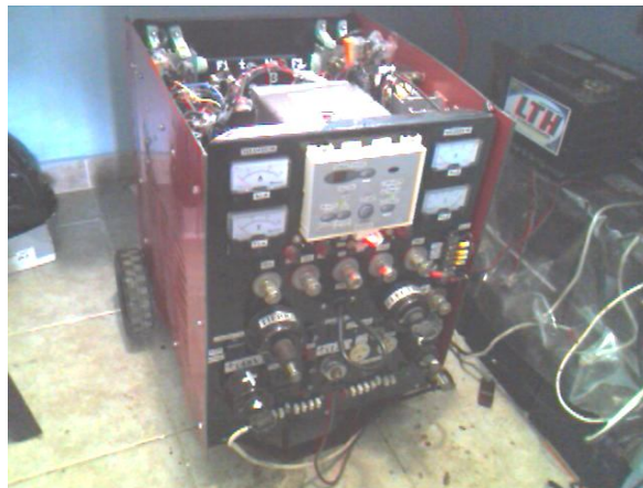
Figura 4.4.3.1. Fotografía que muestra la operación con una mejora sustancial, fuente propia.
