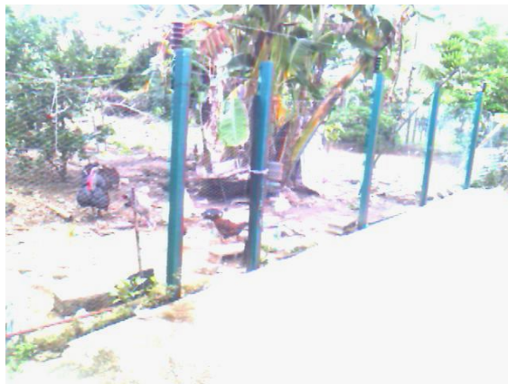
Figura 4.5.1.8. Fotografía que muestra la implementación del Subsistema energizador de cercos eléctricos, donde resalta la instalación del cerco eléctrico, los aisladores que llevan la instalación y la energía, fuente propia.
