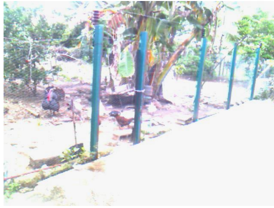
Figura 4.3.2.8. Fotografía que muestra la implementación del Subsistema energizador de cercos eléctricos, donde resalta la instalación, los aisladores que llevan la instalación y los tipos de animales (aves), fuente propia.
