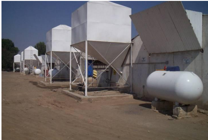
Imagen 9. Granja criadora de aves con instalación de aprovechamiento de Gas LP, 2008.
