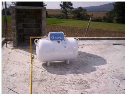
Imagen 5A. Tanque estacionario con capacidad de almacenamiento de 300 lts., 2008.
