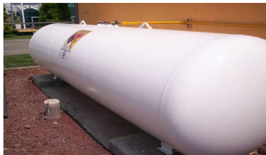
Imagen 5A. Tanque estacionario con capacidad de almacenamiento de 300 lts., 2008.
