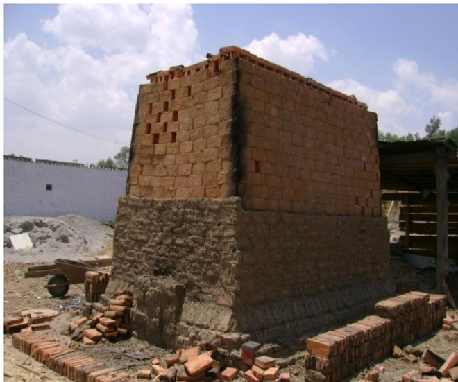
Figura 10. Horno ladrillero (capacidad 7500 ladrillos). Municipio de Ixtapaluca
