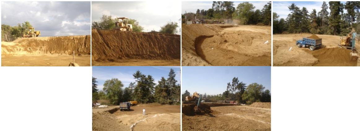
Ante lo anterior, la conformación de los taludes para la ejecución de las gradas del lado sur, lo realicé primero ejecutando los marcos con muros de contención, que propuse adicional al proyecto original para contener lateralmente los límites del talud circular.
