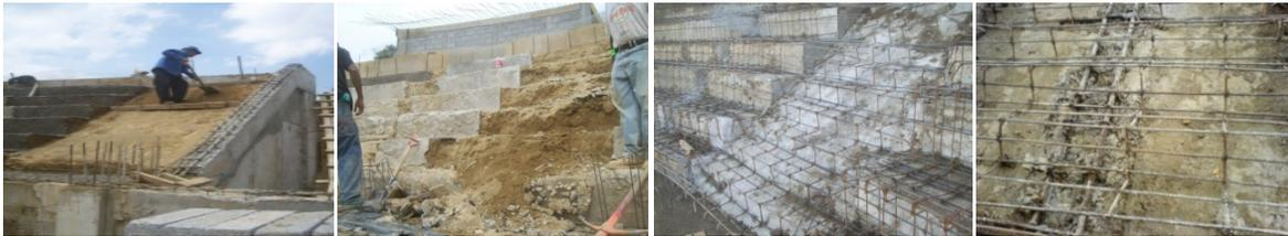
Procedimiento de corte de taludes compactados, conformación de rampas para escaleras, zampeado de superficie como cimbra y armado de acero estructural para refuerzo de escaleras y andadores peatonales.
