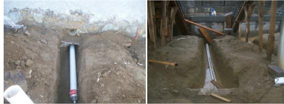
El diseño de este dren se baso en tubo de pvc perforado y zerbado, siguiendo el mismo diametro de la estructura de rueda, alojado al fondo de una excavacion de 30 cm de profundidad, sobre el tubo perforado, se fijo una malla de metal desplegado de 1/2" y sobre este, una capa de grava de 3/4" y sobre ella finalmente, 10 cm de gravilla en todo su desarrollo circular en rueda.
