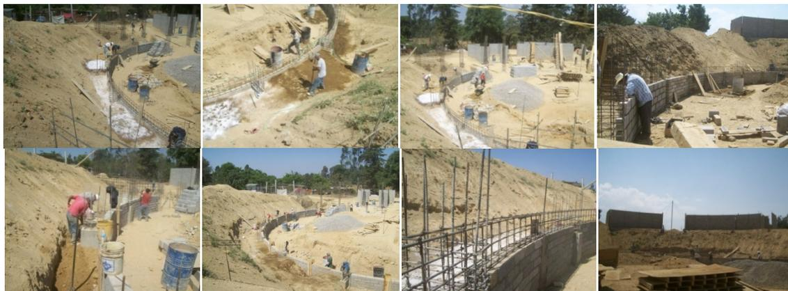
Posteriormente, lleve a cabo la excavación y rellenos escalonados, según los peraltes a obtener en gradas, menos el espesor de un zampeado con tela de gallinero y mortero, para protegerlo del intemperismo de la zona y usarlo a la vez como cimbra, para evitar derrumbes y contaminación del concreto al colar de la estructura de gradas.
