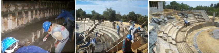
La mayoría de los colados salvo el caso de pequeños ajustes en volumen, fueron ejecutados concreto premezclado, bombas telescópicas o estacionarias según se requería en la posición de los colados como se muestra en las fotografías.
