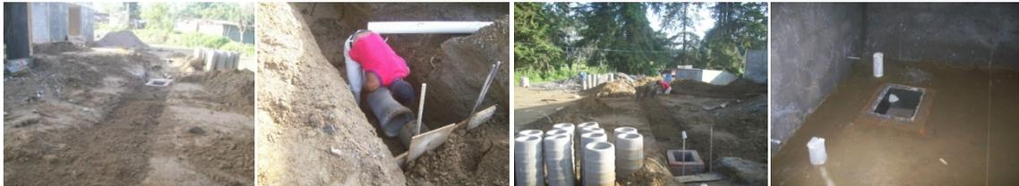
Aprovechando el desnivel provocado para la ejecución de este nuevo proyecto y evitando caer en los errores cometidos en las plazas de los poblados cercanos, propusimos la instalación de un sistema de drenaje de rueda, mediante un dren oculto bajo las estructuras del burladero de madera.
