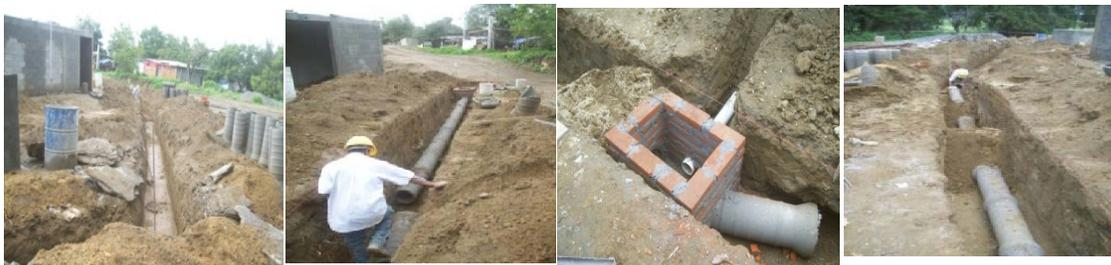
Dicho dren, lo diseñe calculando la captación de la precipitación pluvial, en demasías, según el área del rueda y marcando un bombeo natural del 1% hacia este dren, el cual desembocó al sistema de conducción principal mediante dos líneas, las cuales en un futuro, podrán ser separados para establecer un sistema separado o canalizar estas aguas de lluvia a una cisterna.
