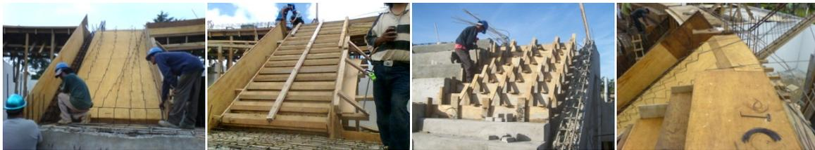
El terminado de las escaleras, se ejecutó en forma similar al de las gradas, solo que requirió de mayor cuidado por las dimensiones de estos elementos, pero de igual manera se colaron integralmente, placas de conexión para el soporte de barandales y protecciones para peatones.
