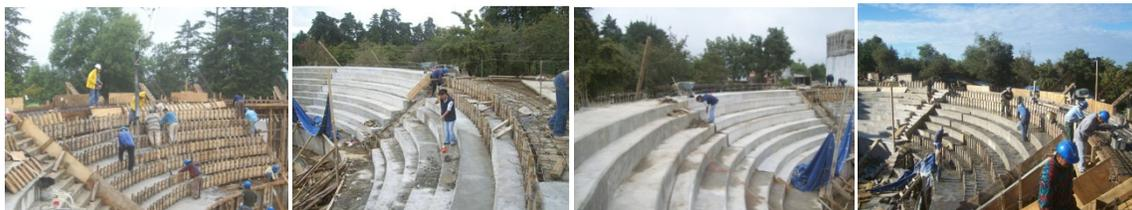
Durante este proceso cabe hacer mención de que se colaron e instalaron integralmente, placas ancladas para fijación de barandales e instalaciones y preparaciones de disparos de instalaciones hidráulicas y sanitarias, pero principalmente eléctricas; además de los anclajes para el caso de la zona oriente, en lo que respecta a las preparaciones para la zona de ampliación (anclajes de estructura).
