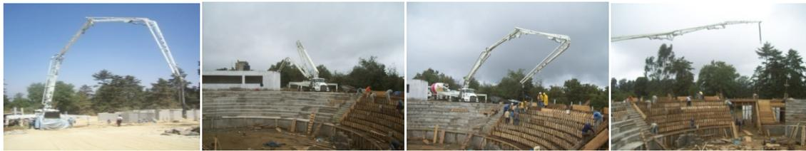
La ejecución de los colados la mayoría el terminado de las gradas se efectúa inmediatamente después del fraguado inicial mediante el chuleo de las superficies verticales y boleado de vértices, no sin reiterar que el terminado escobillado se efectuó mediante el pulido y cepillado de la superficie antes del fraguado inicial.
