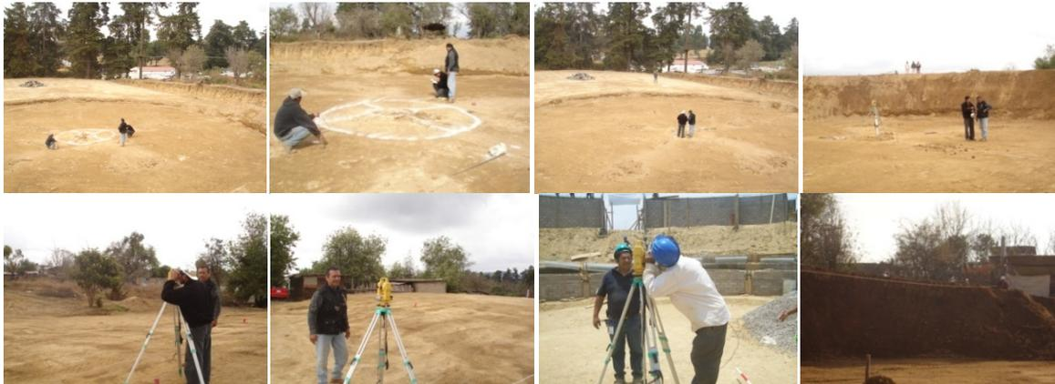
La problemática de trasladar los niveles a los diferentes elementos estructurales de la plaza lo resolví, ubicando de forma definitiva el punto central de la plaza incluyendo la base de una hasta metálica, seccionada en dos partes para alcanzar una altura de 4.5 m
