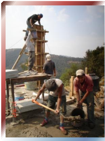
FOTO Nº 46, 47 y 48 – Se muestra el vaciado de concreto en retenidas de torre por medio manual así como si vibrado.
