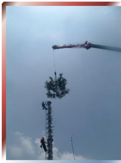
FOTO N° 67 –Montaje de Torre con maniobra
