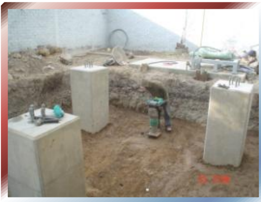
FOTO Nº 59 –Relleno con material de banco.
