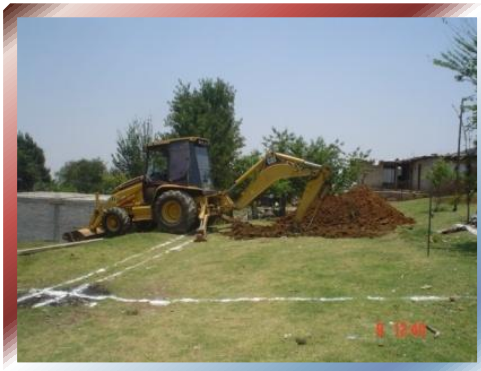
FOTO Nº 16 –Inicio de excavación con maquinaria.
