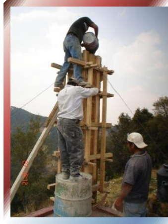
FOTO Nº 46, 47 y 48 – Se muestra el vaciado de concreto en retenidas de torre por medio manual así como si vibrado.
