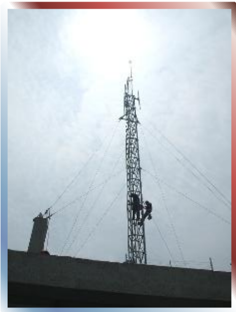
FOTO Nº 1 Y 2 – Se muestra Torre Arriostrada con sus retenidas.
