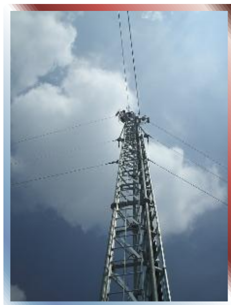
FOTO Nº 1 Y 2 – Se muestra Torre Arriostrada con sus retenidas.
