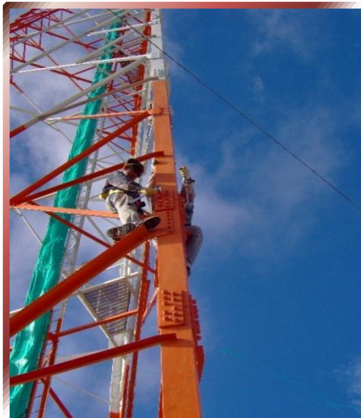
FOTO N° 72 –Apriete de tornillería y verificando que cumpla con el torque requerido.
