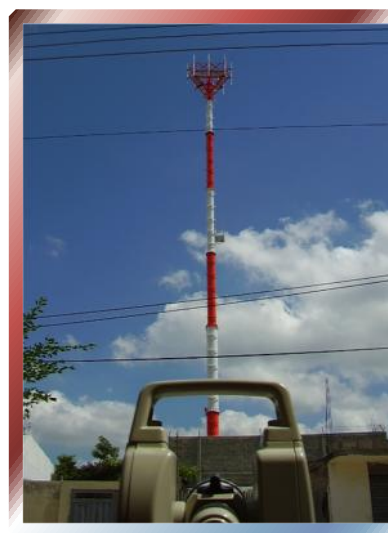
FOTO N° 68 –Verificación de verticalidad de torre.
