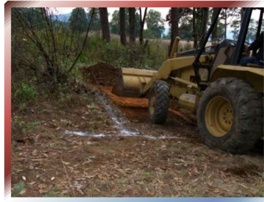
FOTO Nº 8 –Limpieza de Sitio a nivel de Piso.
