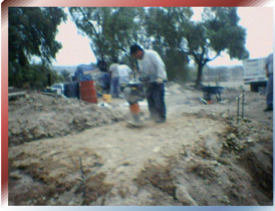
FOTO Nº 123 y 124 – Mejoramiento de terreno con material de banco y compactado con bailarina.
