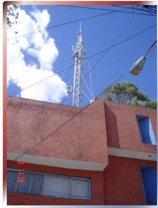
FOTO N° 91 y 92 –Se muestra torre Arriostrada o atirantada sobre inmueble existente, (casa habitacional).
