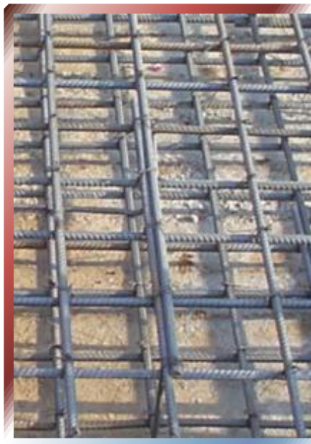
FOTO N° 39 –Traslape e parrilla superior de cimentación de Torre.
