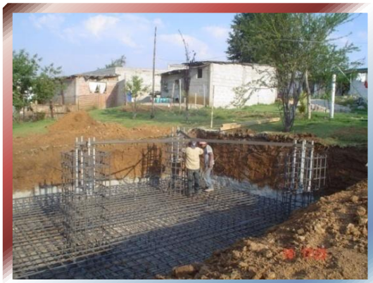
FOTO Nº 22 –Armado de Zapata de torre autoportada.
