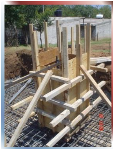
FOTO Nº 40 –Cimbra de dado de cimentación de Torre
