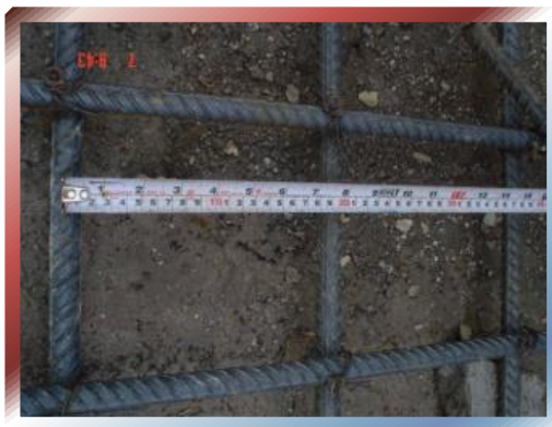
FOTO Nº 31 –Separación entre varillas inferiores de cimentación.
