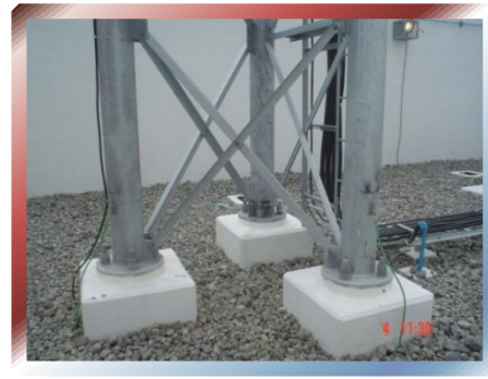
FOTO N° 82 –Aterrizaje de piernas de Torre.
