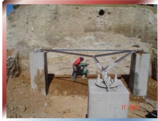
FOTO Nº 60 – Compactado de Limpieza de Sitio a nivel de Piso
