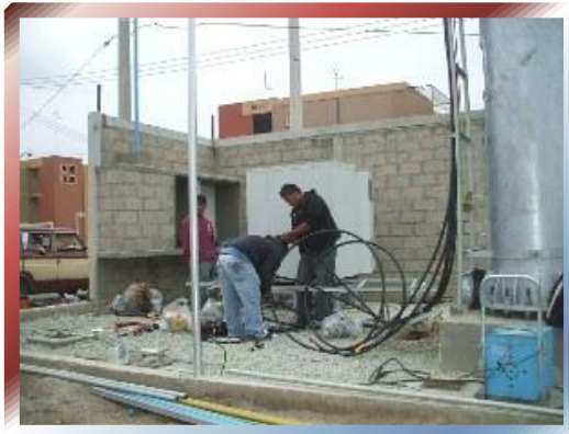
FOTO Nº 99 – Instalación de líneas
