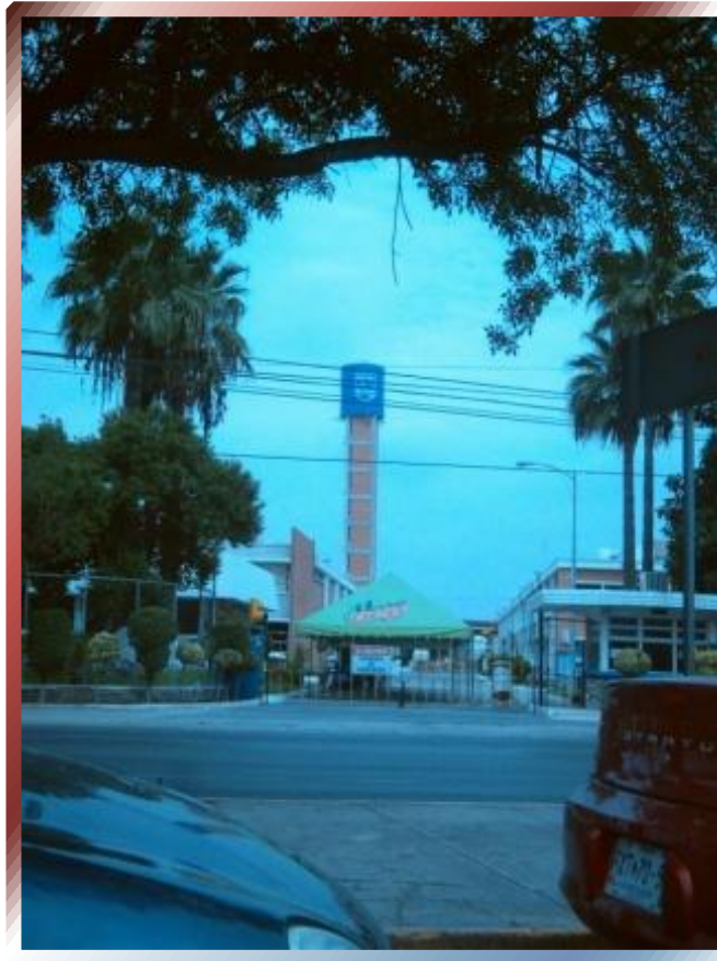
FOTO Nº 132 – Mimetización en zona industrial simulando tanque elevado.
