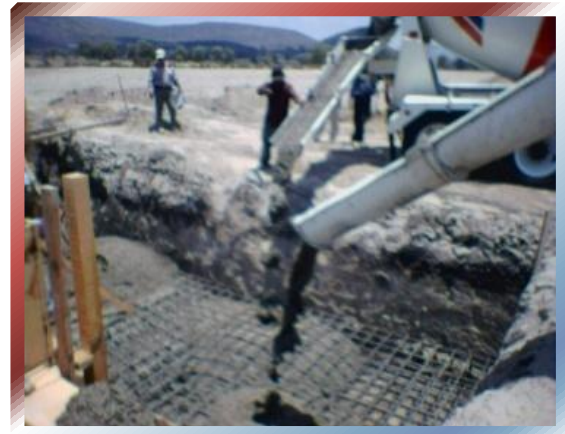
FOTO Nº 54 –Continuidad de vaciado de concreto.
