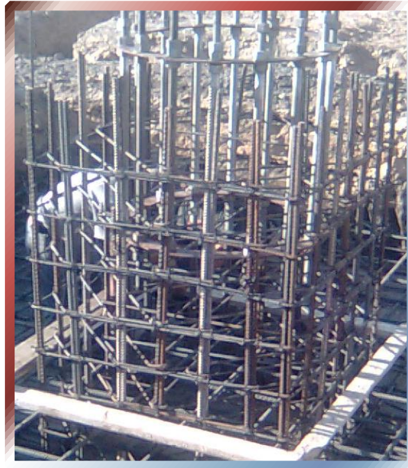
FOTO Nº 30 –Armado de dado de cimentación para e instalación de anclas para Monopolo.
