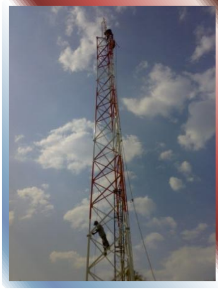
FOTO Nº 70 –Colocación de remate de Torre.
