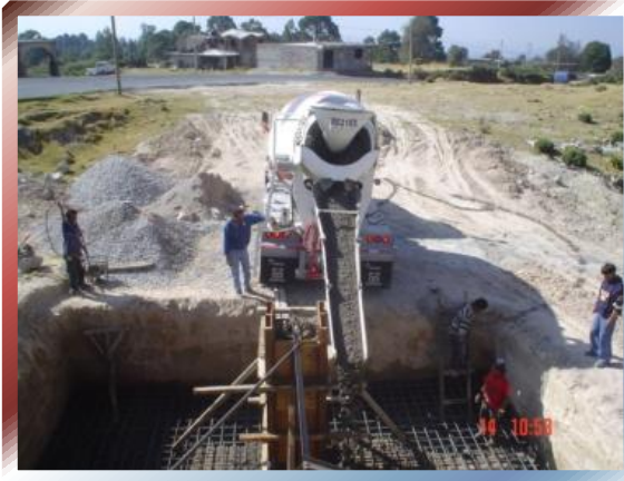
FOTO Nº 51 – Tiro directo de concreto.
