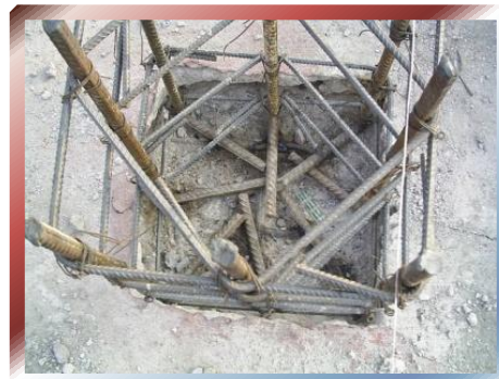
FOTO Nº 37 –Dado anclado de Torre arriestrada.
