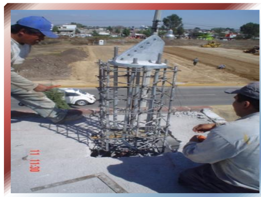
FOTO Nº 27 –Armado de dado de retenida.
