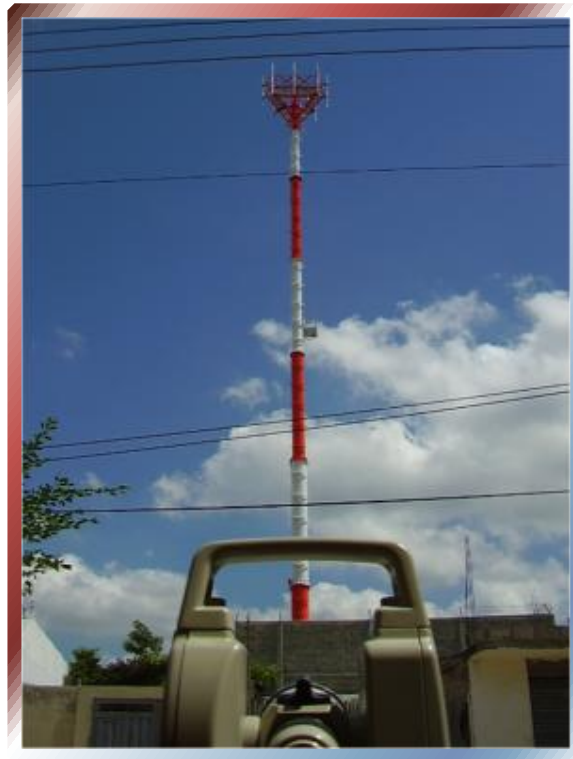
FOTO.№ 93 –Torre tipo Monopolo con plataforma triangular.
