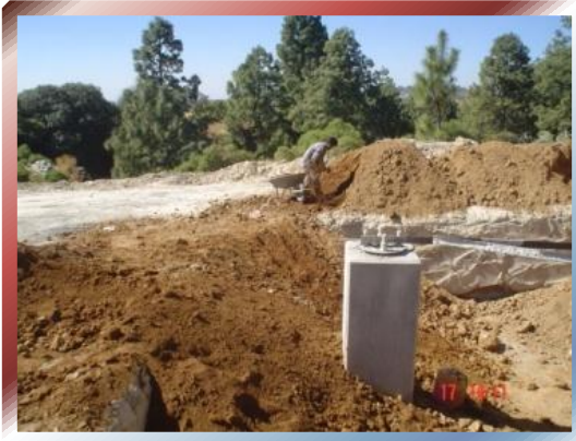
FOTO Nº 59 –Relleno con material de banco.
