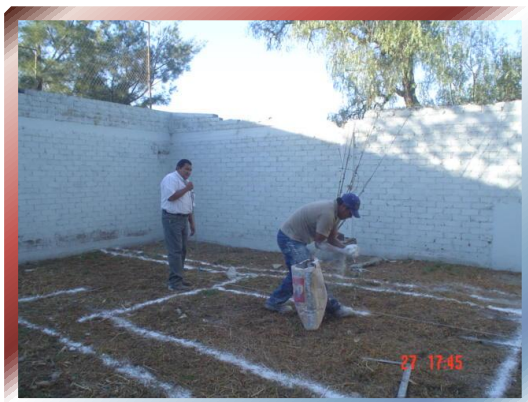
FOTO Nº 14 –Trazo de área de Equipos y perímetro.
