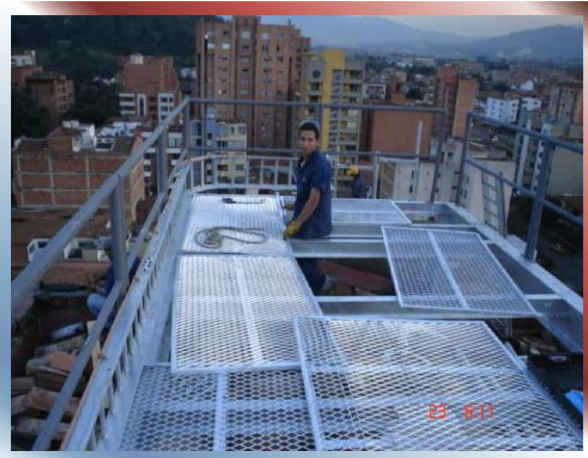
FOTO Nº 126 y 127 – Plataforma Metálica sobre edificio.
