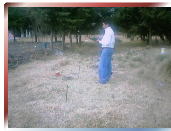
FOTO Nº 6 – Se muestra Prueba de Resistividad utilizando Terrómetro.
