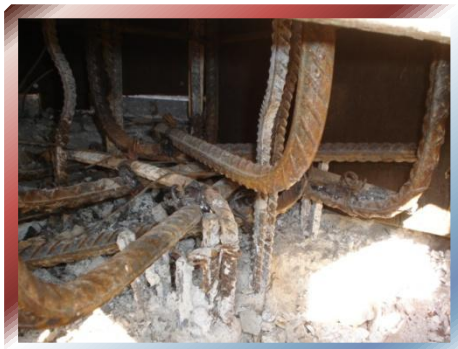
FOTO Nº 36 –Anclaje con grapas y punto de soldadura
