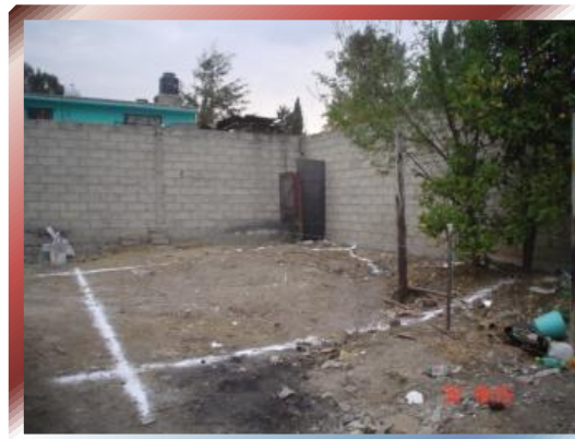
FOTO Nº 13 –Trazo de cimentación de Sitio a nivel de Piso.
