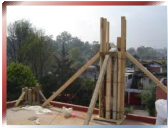
FOTO Nº 43 –Cimbra de dado de retenida y apuntalada.
