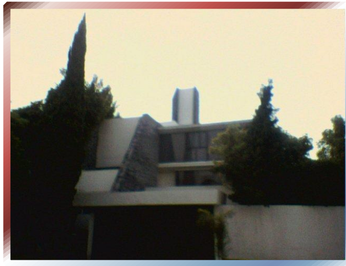
FOTO N° 130 – Mimetización en azotea con diseño similar a inmueble.
