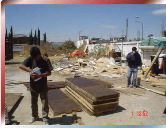
FOTO Nº 44 – Lubricación de cimbra con diesel y aceite quemado.
