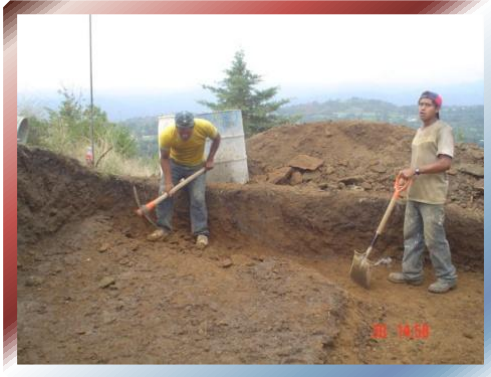
FOTO Nº 20 –Excavación a mano en montaña.
