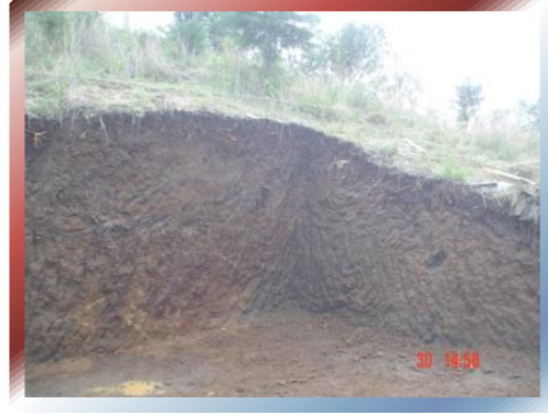
FOTO Nº 21 –Excavación terminada y lista para plantilla.
