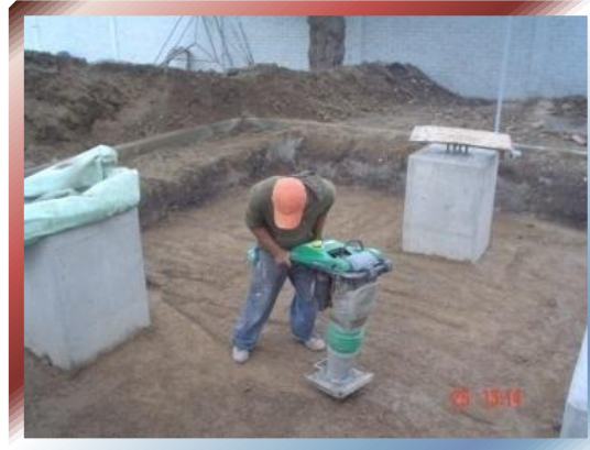
FOTO Nº 60 – Compactado de Limpieza de Sitio a nivel de Piso
