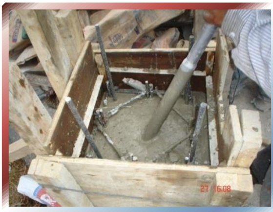
FOTO Nº 49 –Vibrado de concreto en dado de Sitio en Azotea
