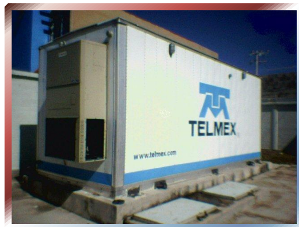
FIG. Nº 18 y FOTO Nº 5– Contenedores con aires acondicionados, dentro de ellos se instalan equipos de telefonía, (Cortesía Radiomóvil Dipsa).
