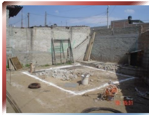
FOTO Nº 11 –Trazo de cimentación.
