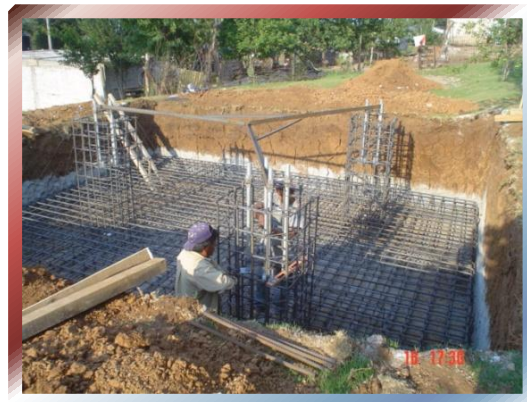
FOTO Nº 23 –Armado de dados y escantillón de torre.
