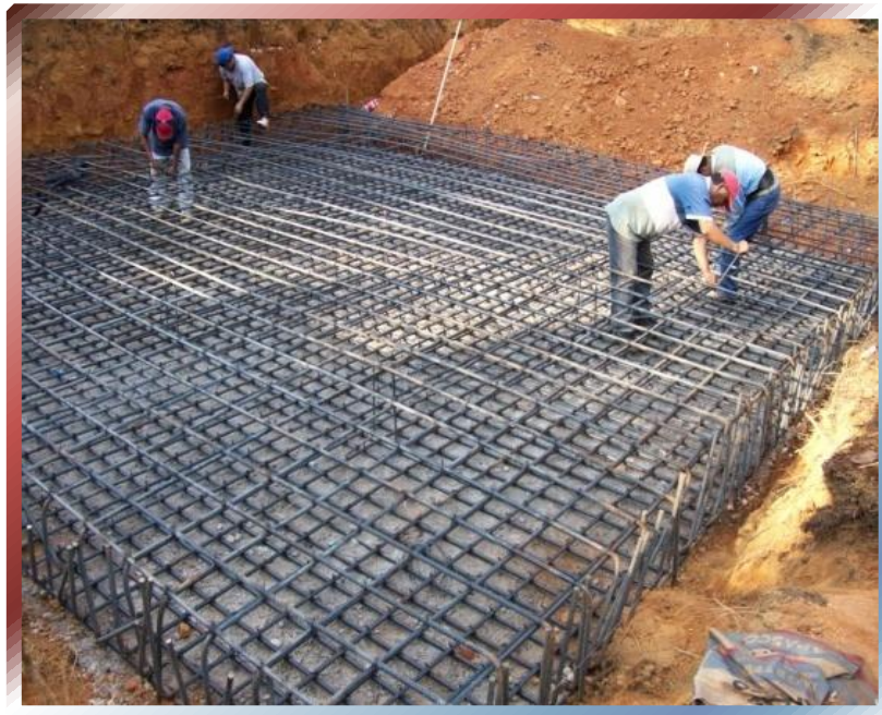
FOTO.№ 29 – Armado de base de zapata de cimentación de Torre.
