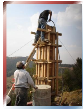
FOTO Nº 46, 47 y 48 – Se muestra el vaciado de concreto en retenidas de torre por medio manual así como si vibrado.
