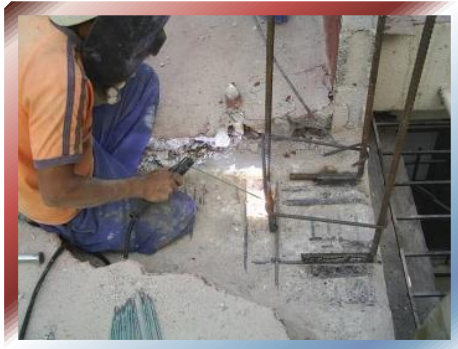
FOTO Nº 34 – Anclaje por soldadura a estructura existente.
