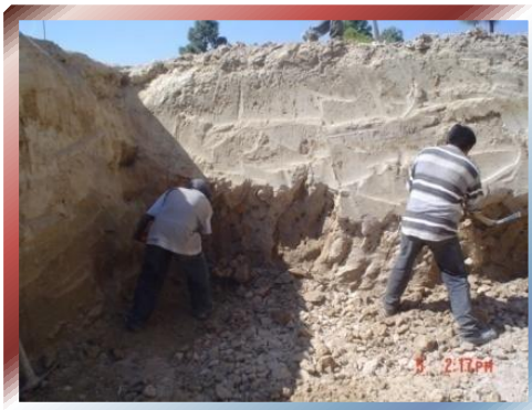
FOTO Nº 18 –Afine de excavación de zapata de cimentación.
