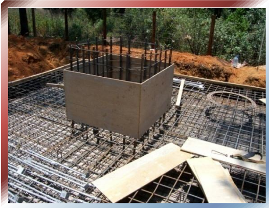
FOTO Nº 24 –Armado de dado para Torre Monopolo
