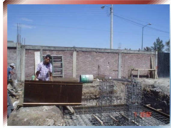
FOTO Nº 45 – Cimbra lista para instalarse.
