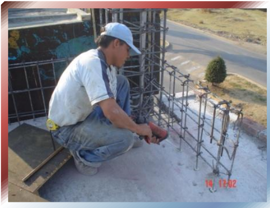
FOTO Nº 26 –Armado de contra fuerte de retenida en Azotea
