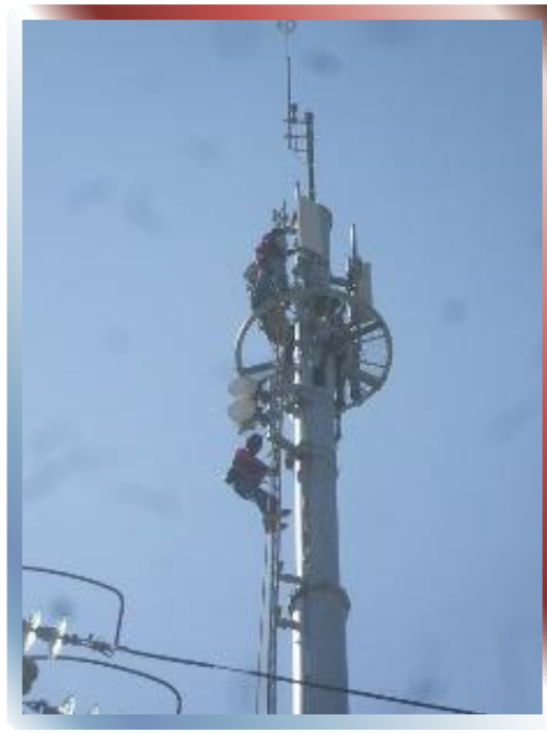
FOTO N° 98 – Instalación de Antenas.
