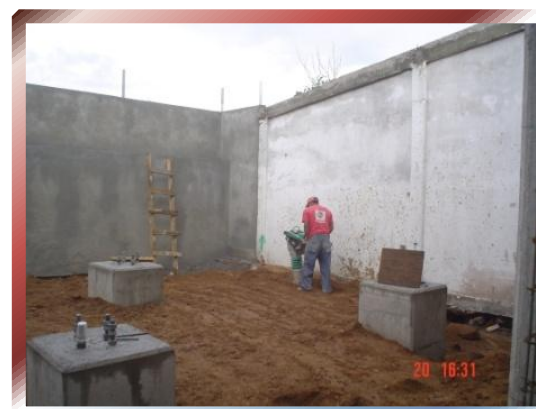
FOTO Nº 61, 62, 63, y 64 –Compactación de Relleno con bailarina en capas de material de banco de 30 cm. como máximo.
