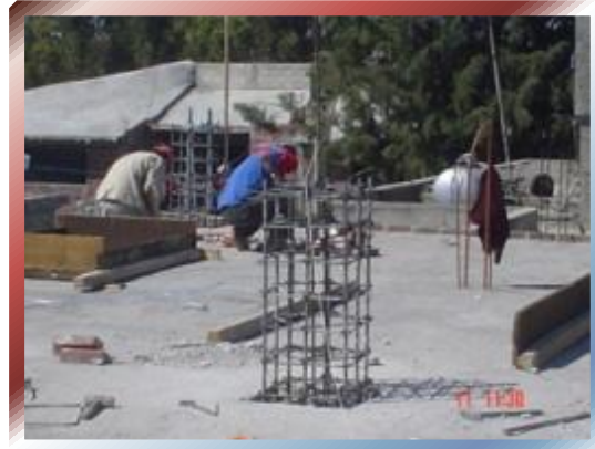
FOTO Nº 25 –Armado de dado central para Torre Arriestrada.
