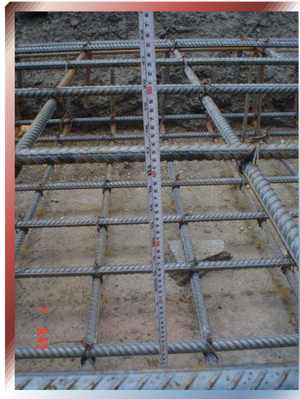
FOTO Nº 33 –Separación de armado de cama inferior y cama superior de cimentación.
