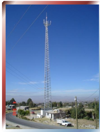
FOTO N° 90 –Torre Autoportada Triangular
