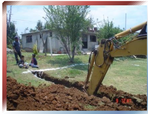
FOTO Nº 17 –Excavación de zapata perimetral del Sitio.
