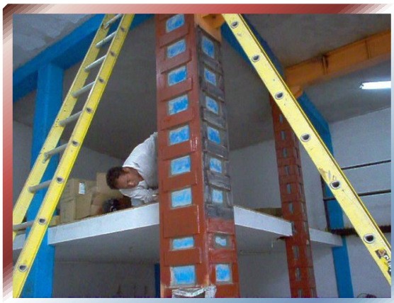
FOTO Nº 128 y 129 –Reforzamiento de estructura sobre inmueble a colocar EB.
