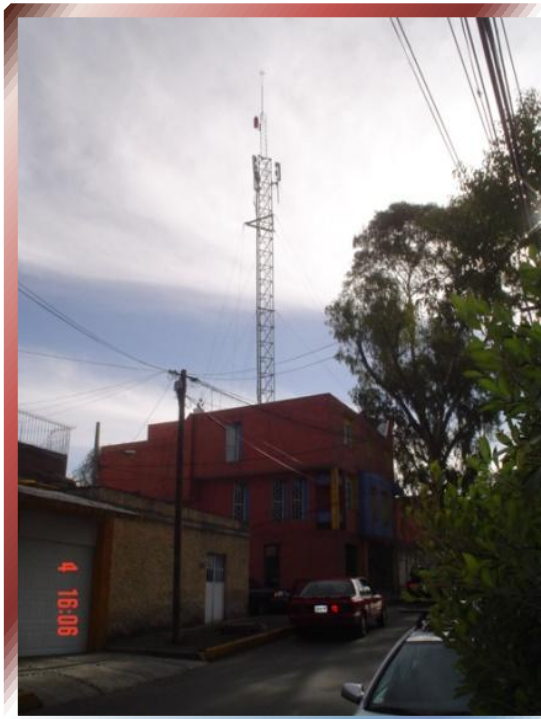
FOTO N° 91 y 92 –Se muestra torre Arriostrada o atirantada sobre inmueble existente, (casa habitacional).
