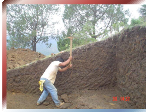
FOTO Nº 19– Excavación a mano en terreno de acceso difícil.
