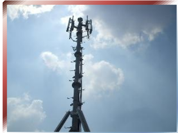
FOTO.№ 94 y 95 – Mástil de 12 metros con soportes bandera
