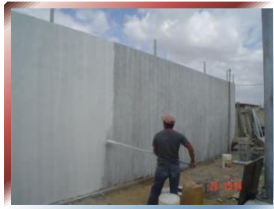
FOTO Nº 78 –Muro perimetral sin colindancia.
