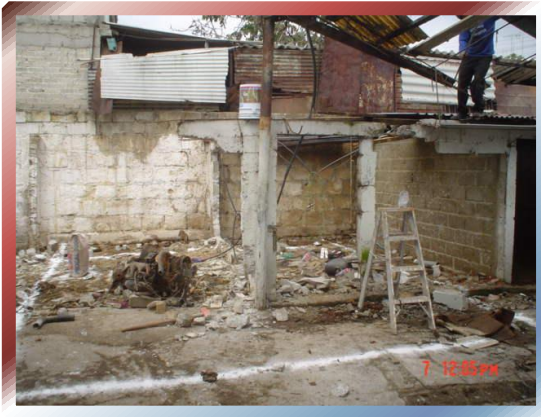
FOTO Nº 7 –Limpieza de Sitio en Azotea con demolición
