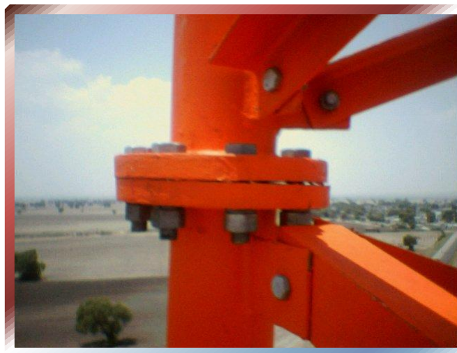
FOTO Nº 71 –Verificación de ensamble de bridas en piernas de Torre.
