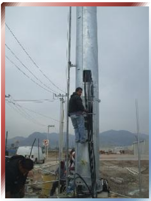
FOTO N° 97 – Instalación de líneas en Monopolo
