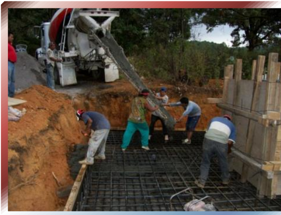
FOTO Nº 53 –Inicio de vaciado de concreto en esquina.
