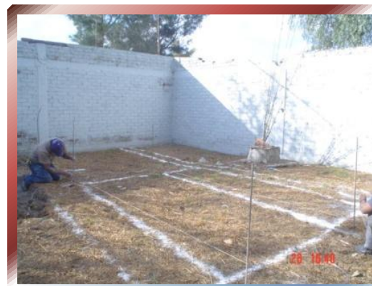
FOTO Nº 15 –Colocación de niveles del Sitio.
