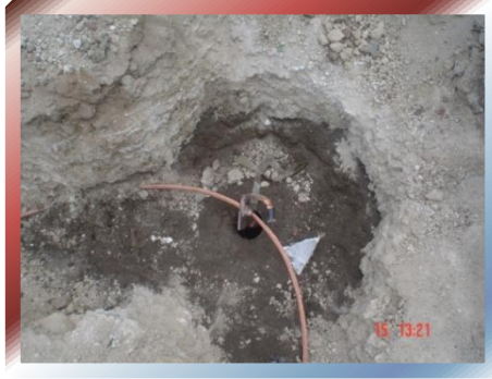
FOTO N° 81 –Unión de sistema de tierras con Soldadura
