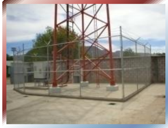
FOTO No 80 –Malla ciclónica perimetral.
