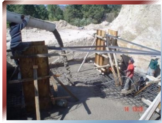
FOTO Nº 52 –Llenado de dados y vibrado.
