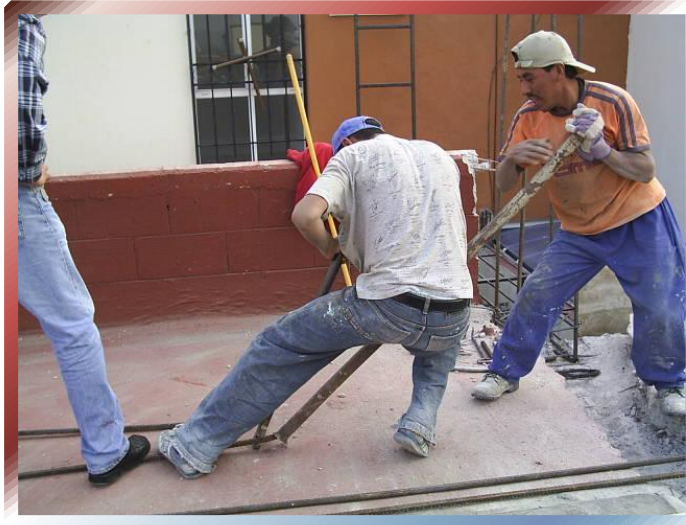
FOTO N° 38 –Dobles de varilla por medio manual utilizando la grifa.
