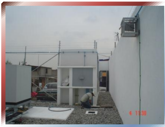
FOTO Nº 75 –Nicho NQOD12 terminado.
