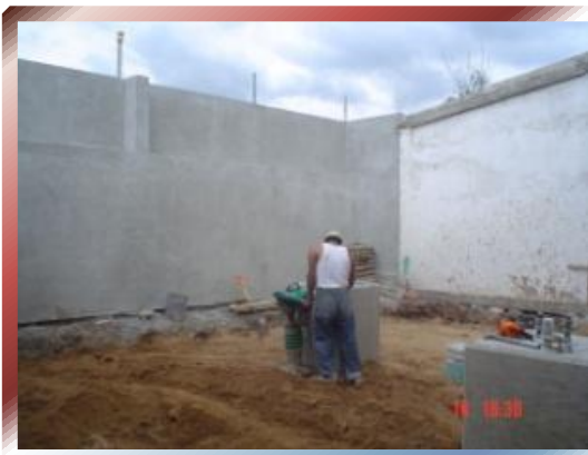
FOTO Nº 61, 62, 63, y 64 –Compactación de Relleno con bailarina en capas de material de banco de 30 cm. como máximo.
