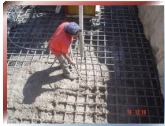
FOTO Nº 56 –Vibrado de concreto simultanea al tiro.
