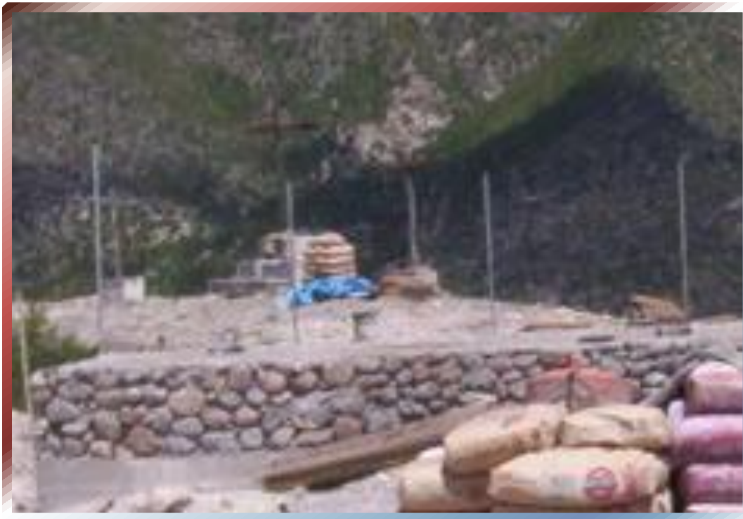
FOTO N° 118 – Cimentación especial, con concreto Ciclópeo.
