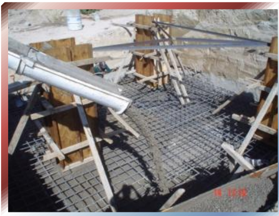
FOTO Nº 55 –Distancia máxima de vaciado de concreto.
