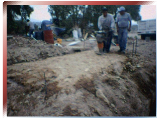
FOTO Nº 123 y 124 – Mejoramiento de terreno con material de banco y compactado con bailarina.
