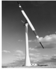
Figura 2.3: Torre tubular de acero del MOD-2 (1982).
