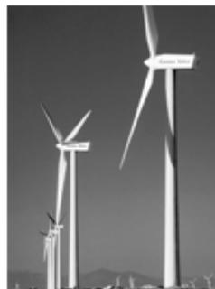
Figura 2.5: Torres tubulares de turbina de viento del grupo GAMESA .
