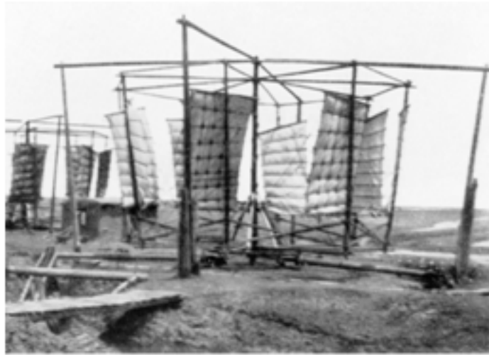
Figura 1.2: Molino de viento de la china antigua para el bombeo de agua.
