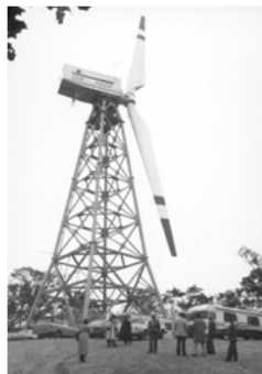
Figura 2.1: MOD-1 con torre de celosía (1982).
