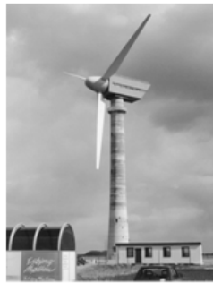
Figura 2.2: Torre de concreto del probador de turbinas Tjaereborg (1986).
