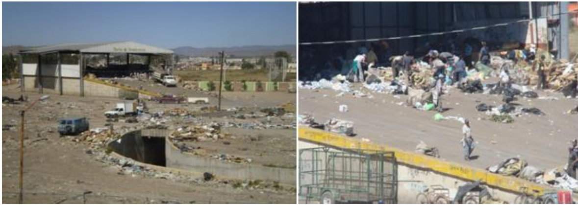
Figura 12. Panorámica de la planta de transferencia.
