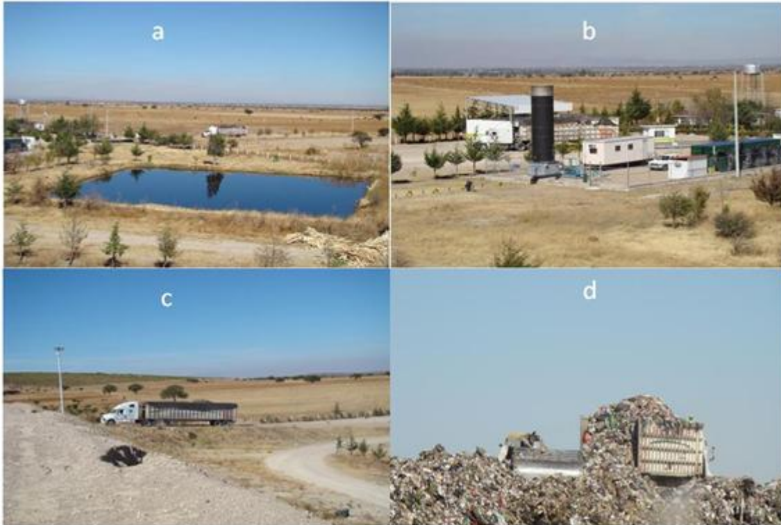
Figura 5. Relleno sanitario del municipio de Durango. a) Entrada y laguna de captación de lixiviados, b) báscula y sistema de captación de biogás, c) camión dirigiéndose a celdas y d) distribución de la basura en las celdas.
