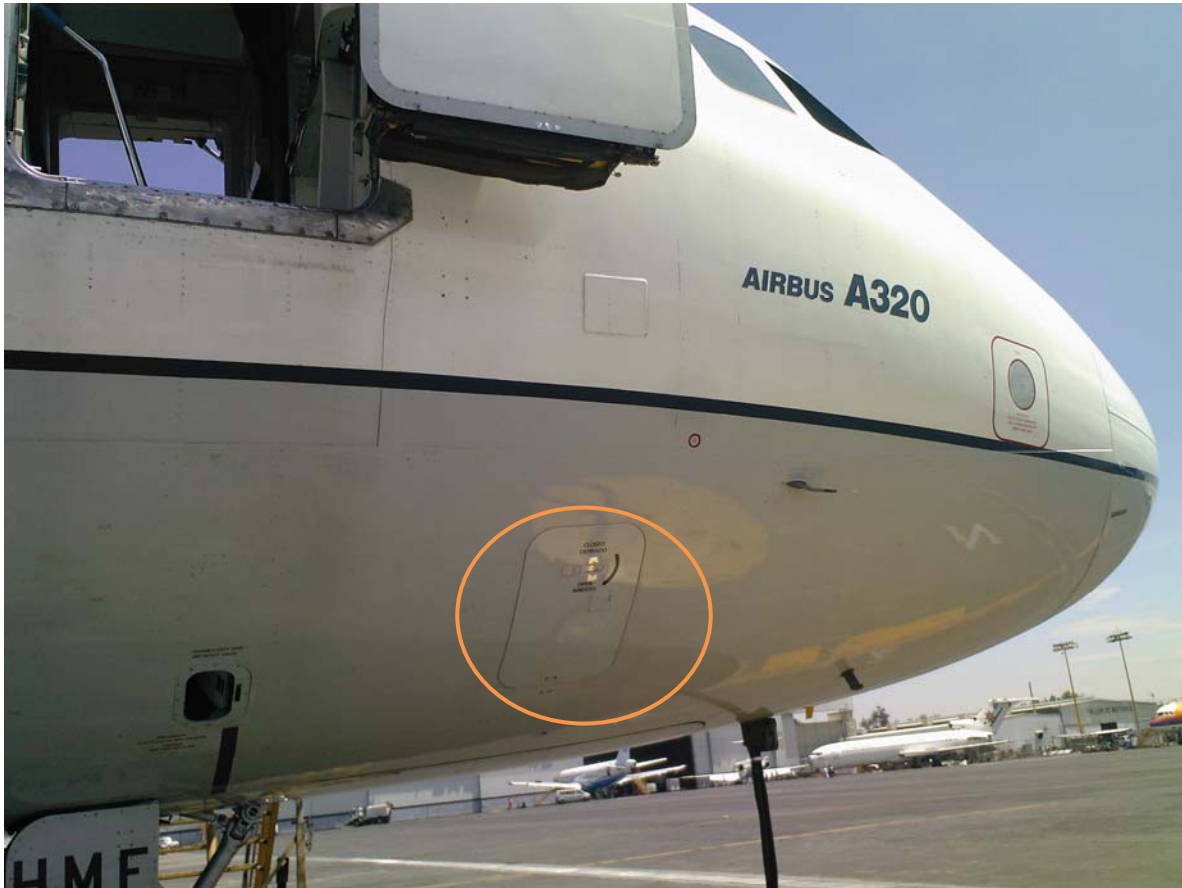
Figura 2.1.- Compartimento de Baterías, dentro de este se encuentran las 2 baterías y los 2 BCLs.
