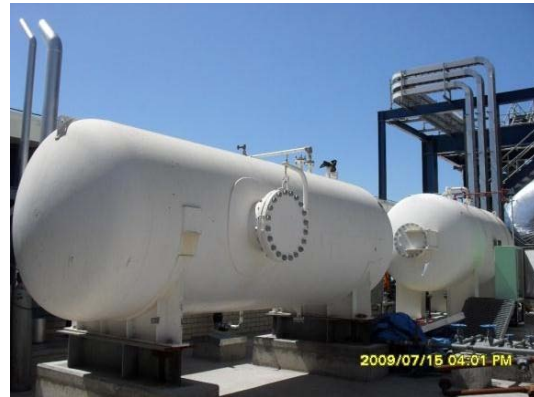
Fig. 3.1. y 3.2. Ejemplos de silletas en recipientes de almacenamiento.
