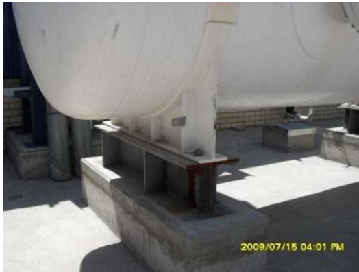
Fig. 3.1. y 3.2. Ejemplos de silletas en recipientes de almacenamiento.
