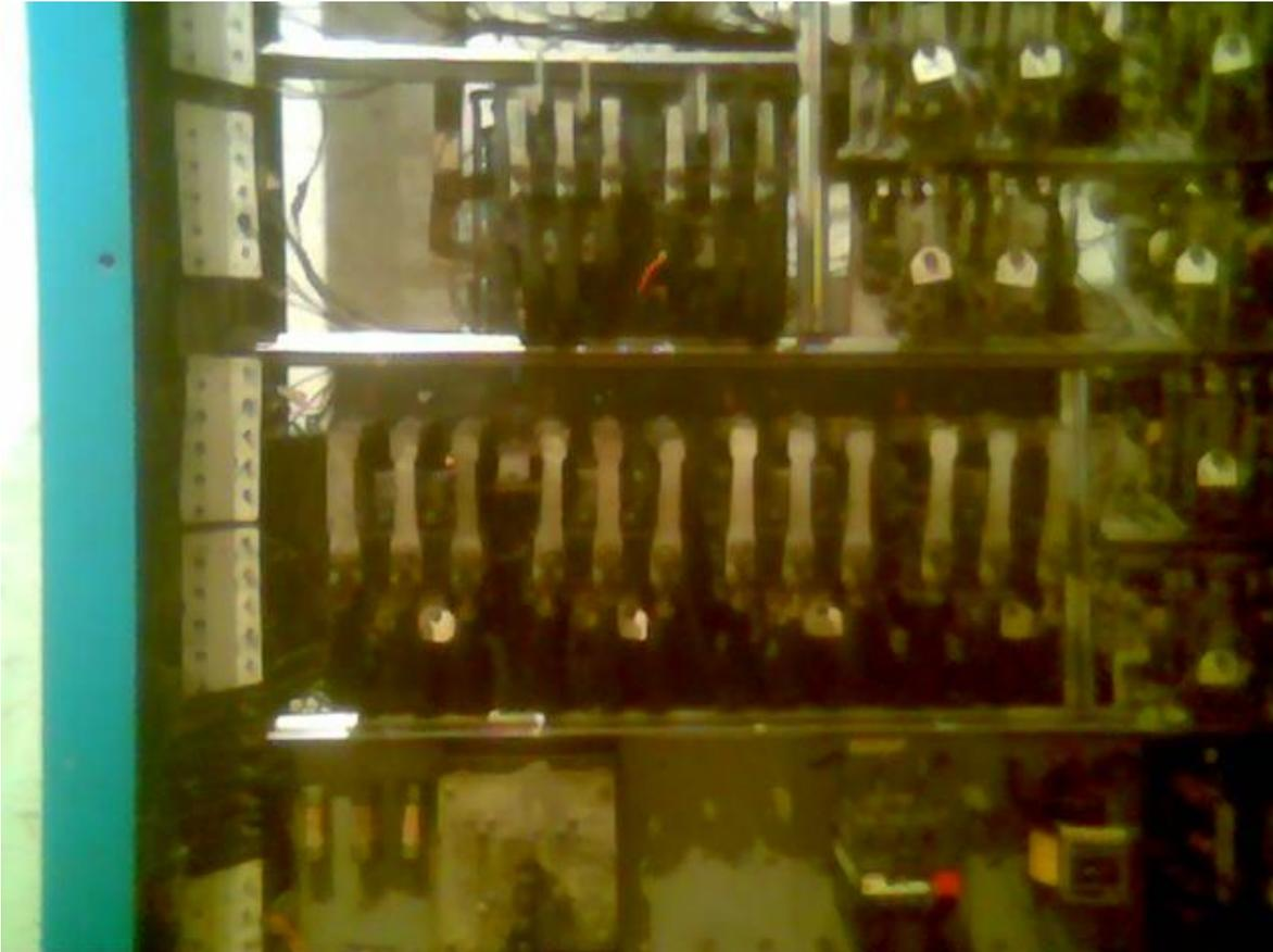
*Fig. 78. Fotografía de Tablero OTIS. Los dos contactores de la derecha son los encargados de liberar las resistencias cuando el elevador va llegando a su destino. Los dos primeros son los de arranque y paro de subir y de bajar . Utilizan a su entrada 3 resistencias que ajustan la velocidad estándar de 1 m/seg*
