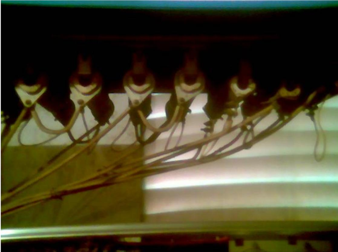
*Fig. 76. Nueve resistencias de frenado lento en Tablero Otis. Las 3 primeras sirven para ajustar la velocidad a 1 m/seg. Las otras 6 corresponden a dos contactores de frenado lento. 3 cuando Baja el elevador y 3 cuando sube*
