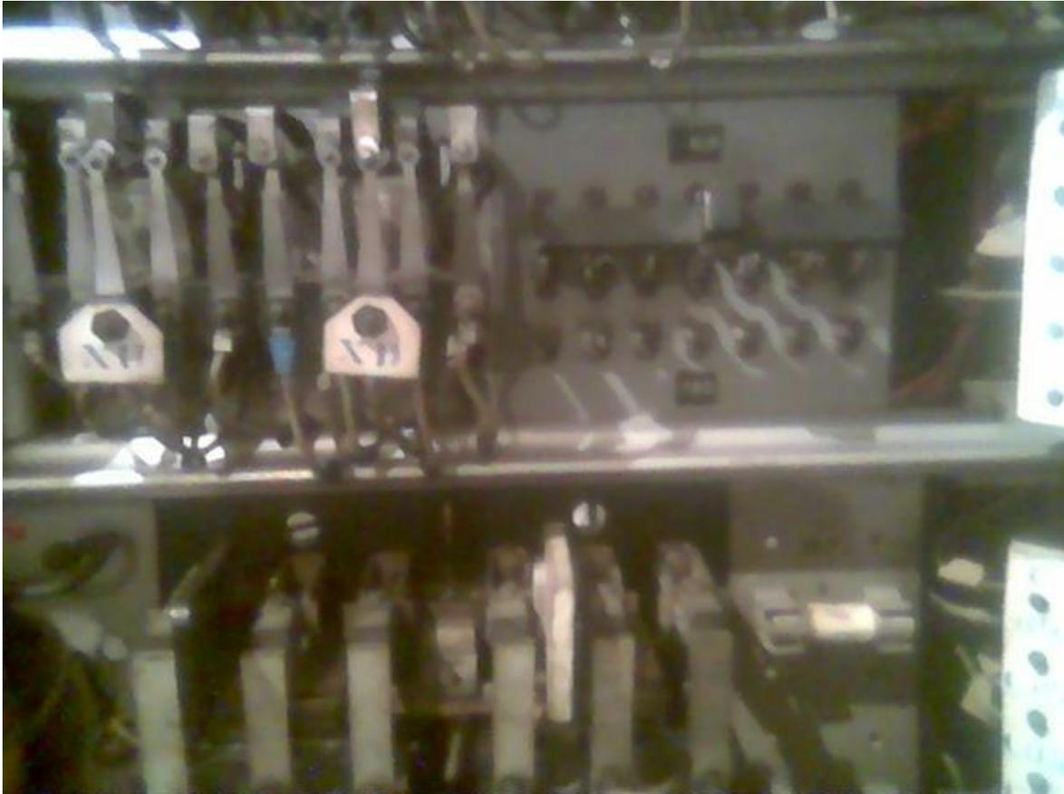
*Fig.73 Dos contactores en la parte de abajo quedarían reemplazados por el doble contactor de la fig. 72*
