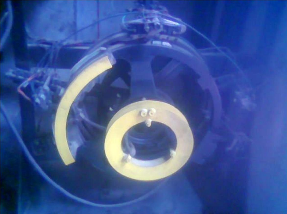
*Fig.24 Localizador de Pisos del Tipo Rotativo*
