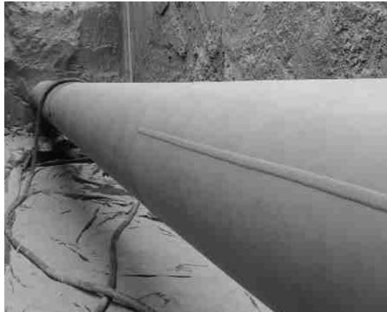
Figura 12.- Tubería API 5L Soldada mediante el proceso SAW
