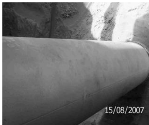
Figura 13.- Tramo de tubo API 5L soldado mediante el proceso ERW
